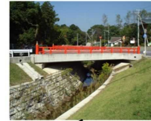
建部大社周辺の橋の欄干
