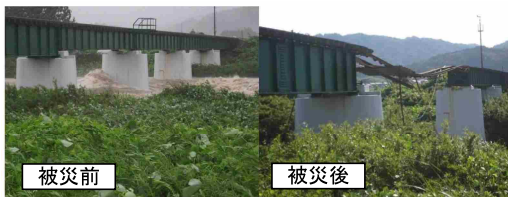
杣川・信楽高原鉄道杣川橋梁流失 (平成 25 年 9 月洪水)
