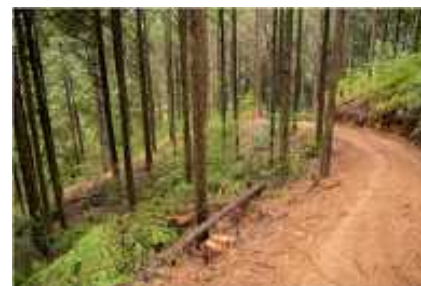
＜作業道整備後の様子＞
