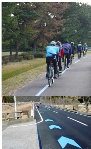
自転車走行空間整備
