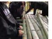
床の仕上げ材として、丸竹を デッキを作る。足が抜けないよ うに隙間なく敷き詰めてロープ
