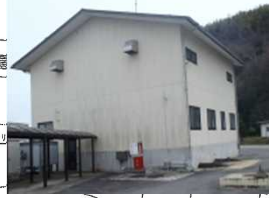
改修後の排水機場
