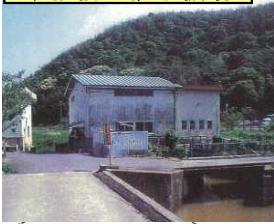
改修前の排水機場
