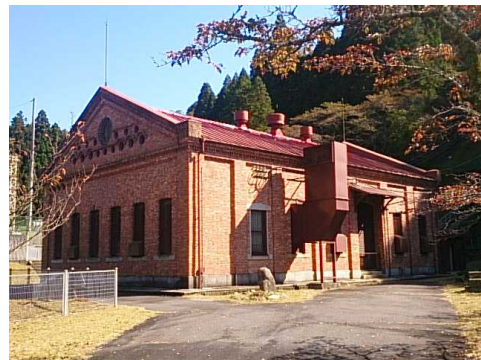
大戸川発電所 (大津市上田上牧町)
