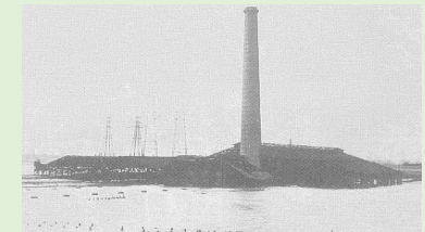
地盤沈下で海に沈んだ工場
