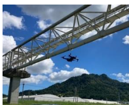
水管橋点検への空中ドローンの活用
