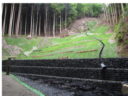
治山工事(木柵工・木筋工)
