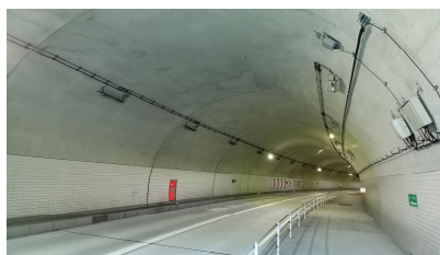
トンネル内 LED照明に交換
