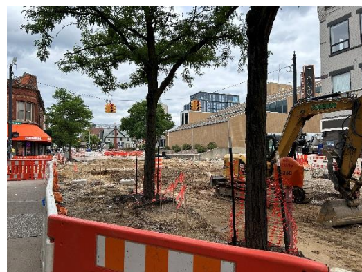
アナーバー市内交差点の工事は化石発掘現場のよう。
