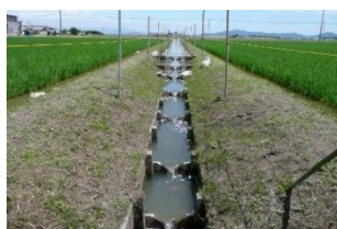
魚道(魚の通り道)
