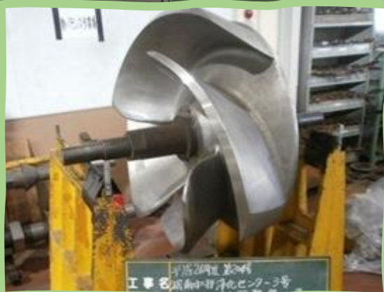
汚水ポンプの分解整備(羽根車)
