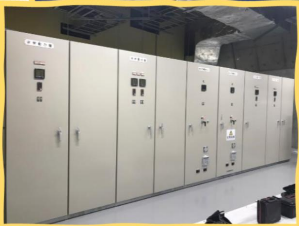
金亀公園第1種陸上競技場 LED照明設備 キュービクル盤
