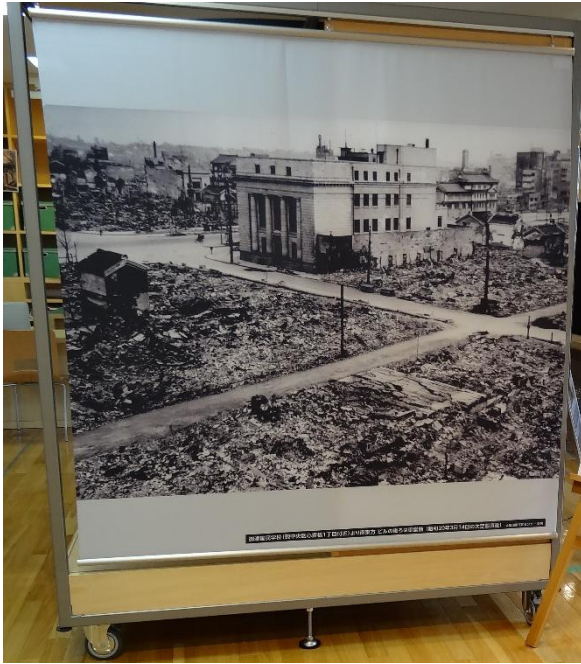
パナール写真：御津国民学校（現中央区心斎橋1丁目付近） より南東方 ビルの後ろは御堂筋（昭和20年3月14日 の大空襲直後） （公財）大阪国際平和センター提供
