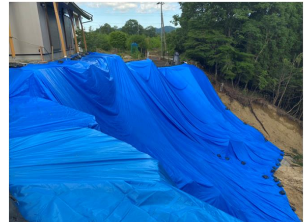
写真：ブルーシート設置状況
