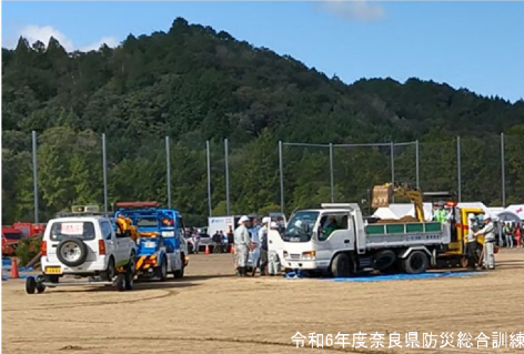
写真 土砂撤去、放置車両移動訓練
