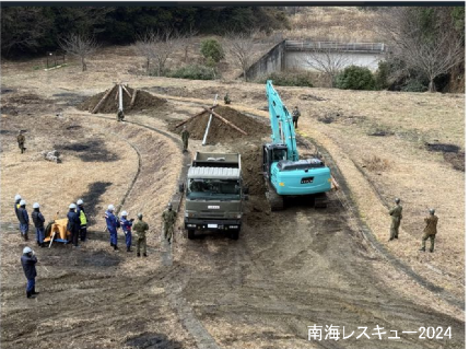
写真 倒壊電柱の撤去訓練(自衛隊連携)
