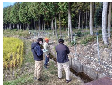
現地調査の様子
