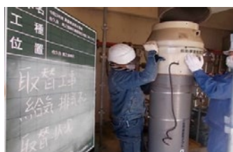
前処理室排気ファン更新
