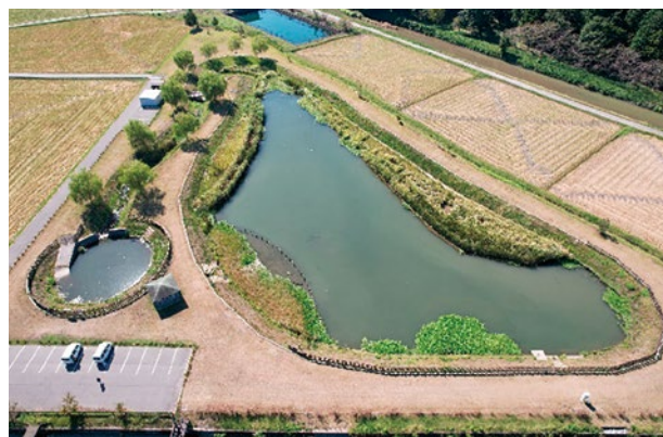
白鳥川中流1期地区浄化池（東近江市）
