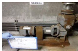
機能診断調査（汚泥引抜ポンプ）
