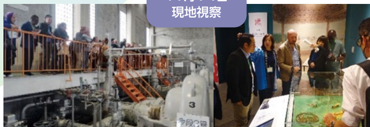
日野川第一段揚水機場
