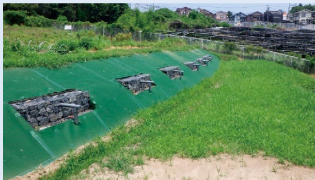
地すべり防止対策（水抜きボーリング工）
