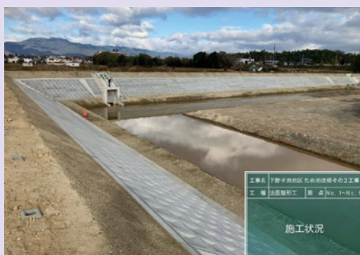
改修中のため池
