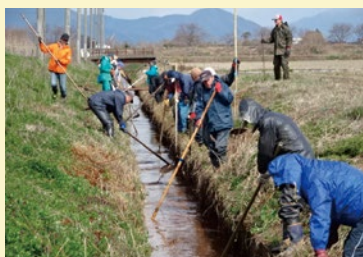
水路の泥上げ
