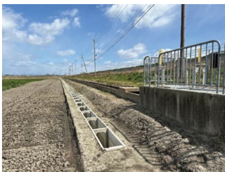
排水路の整備（近江八幡市）
