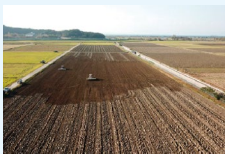
畦畔除去による大区画化
