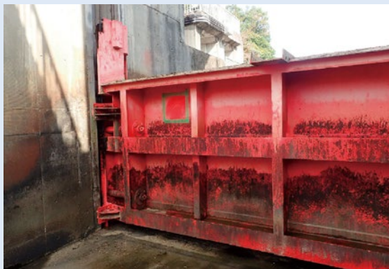
水門扉（改修前）
