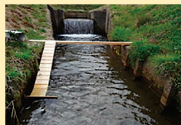
水路からの脱出施設
