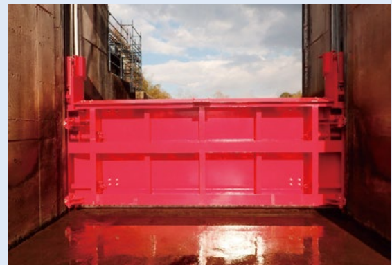
水門扉（改修後）
