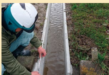
老朽化した用水路の補修・更新
