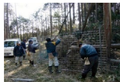
獣害防止柵の補修
