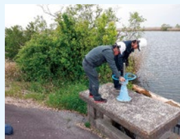
ゲートの点検
