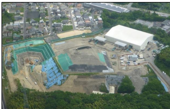
平成28年5月(工事中)
