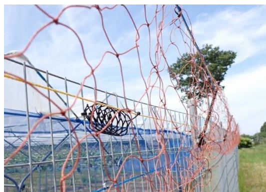
トリカルネットの筒を設置
