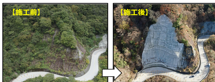
法面对策の状況【国道 306 号/多賀町】
