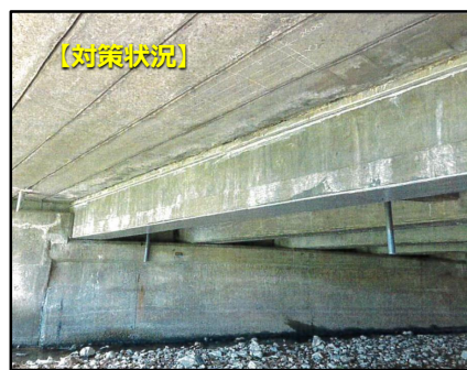
損傷・修繕 (断面補修) 状況【北川橋/長浜市】
