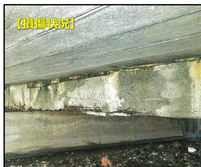
損傷・修繕 (断面補修) 状況【北川橋/長浜市】
