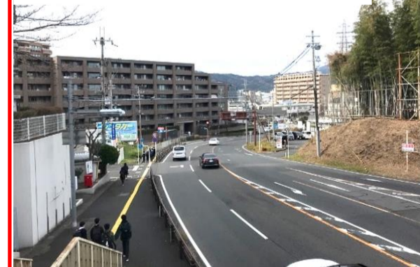
④大津インター線 電線地中化事業（本宮）
