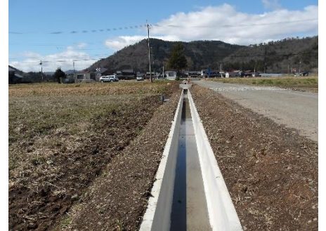
老朽化した水路を改修
