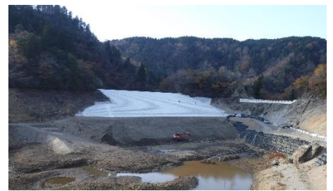
淡海地区ため池耐震化事業 堤体改修工事中の状況
