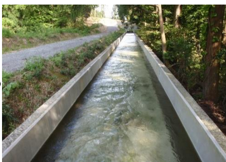
安曇川左岸2期地区かんがい排水事業 用水路内面ライニング（施工完了後）
