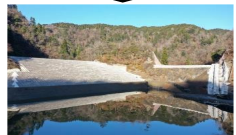
淡海地区ため池耐震化事業 堤体改修工事中の状況
