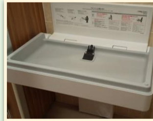
トイレ内ベビーシート整備
