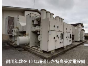
耐用年数を10年超過した特高受変電設備
