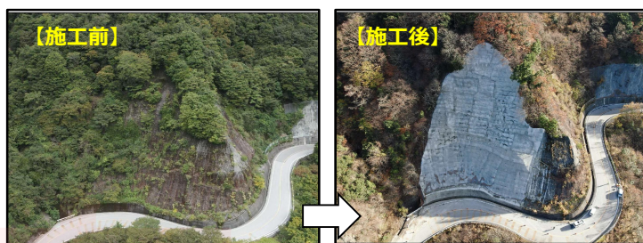
法面对策の状況【国道306号/多賀町】
