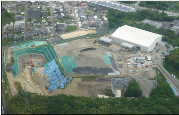
平成28年5月(工事中)
