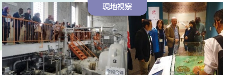
日野川第一段揚水機場
