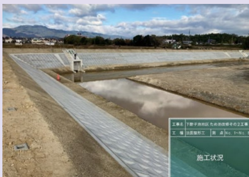
改修中のため池
