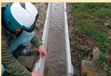
老朽化した用水路の補修・更新
