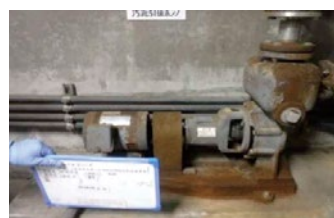
機能診断調査（汚泥引抜ポンプ）
