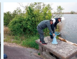
ゲートの点検
