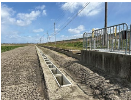
排水路の整備 (近江八幡市)
