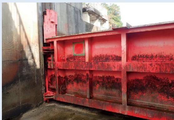
水門扉 (改修前)
