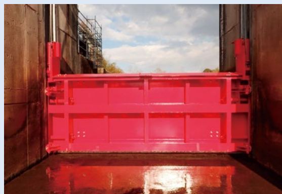
水門扉 (改修後)
