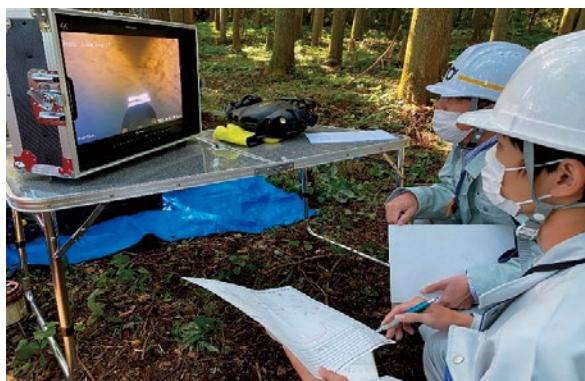
用水路の内部状況を診断するためのビデオカメラ調査
