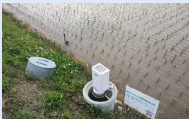
自動給水栓の設置（水管理の効率化）
