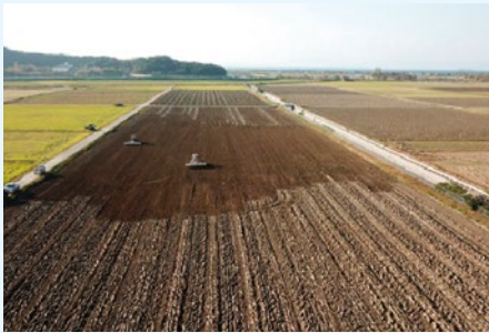
畦畔除去による大区画化
