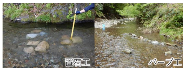
写真 設置した石組みの一例
