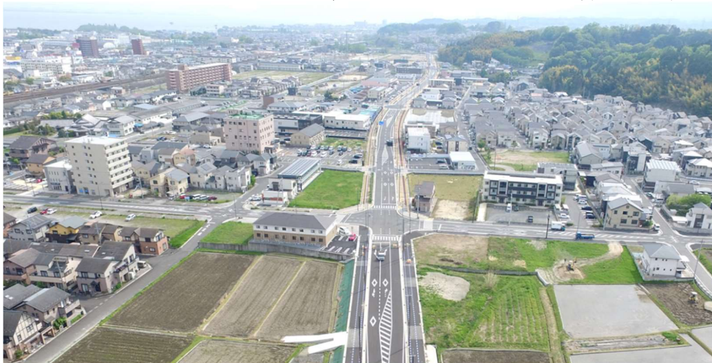
堅田駅西口土地区画整理事業 大津市
