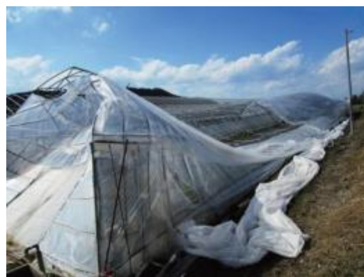
台風による農業用ビニルハウスの倒壊 （2018年9月の台風21号）
