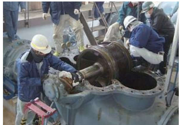
揚水ポンプの長寿命化に向けた機能診断・評価
