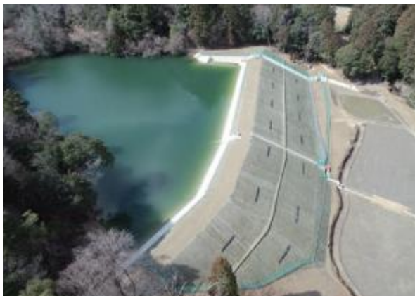
整備された農業用ため池
