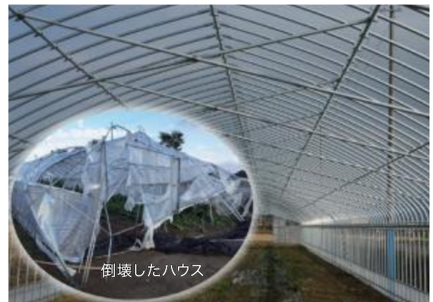
台風等による倒壊を防ぐパイプハウスの補強
