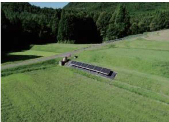
法面への太陽光パネルの設置
