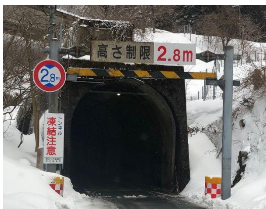
写真1 柳ヶ瀬トンネル
