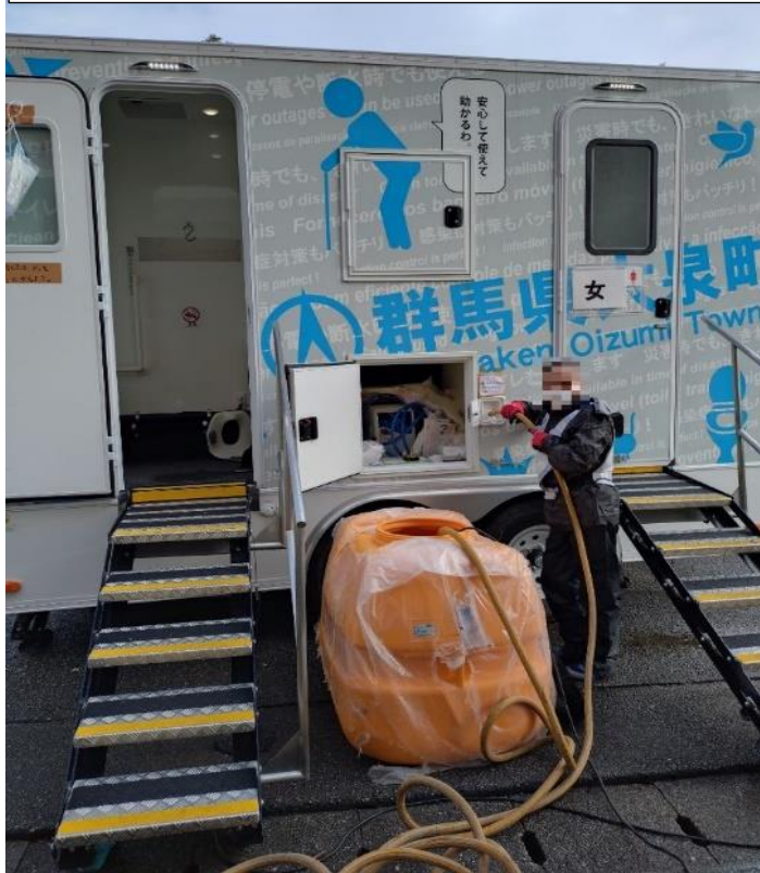
トイレカーへの給水作業
