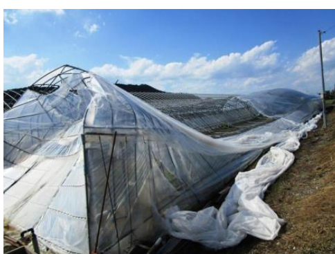
283 台風による農業用ビニルハウスの倒壊 (2018年9月の台風21号)
