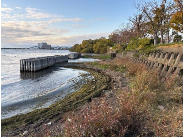
R6施工後状況(R7.11.19)
