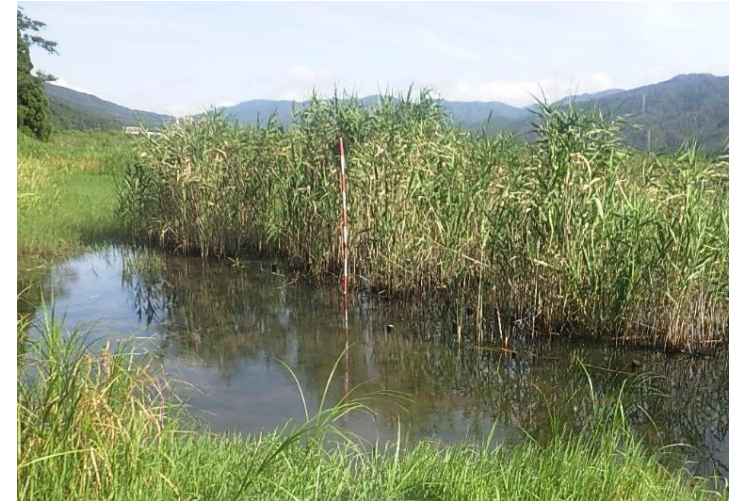
施工後状況(R7.8.28)
