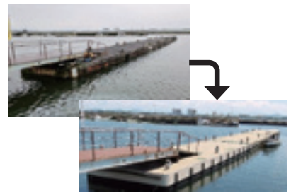
漁港施設(浮棧橋)の長寿命化
