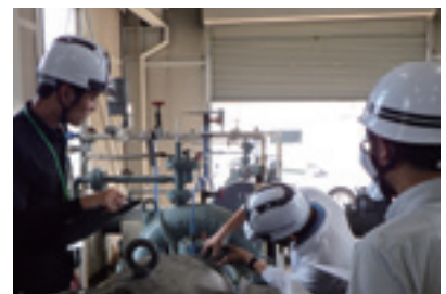
ポンプの機能診断調査
