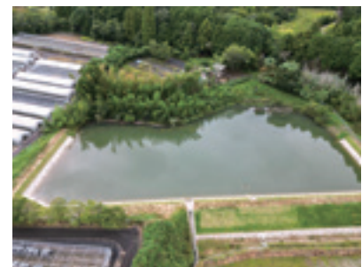
改修後のため池
