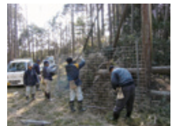
獣害防止柵の補修
