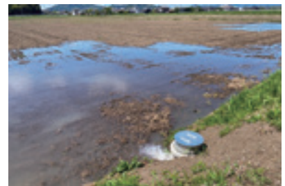
用水路をパイプラインに更新（愛荘町）
