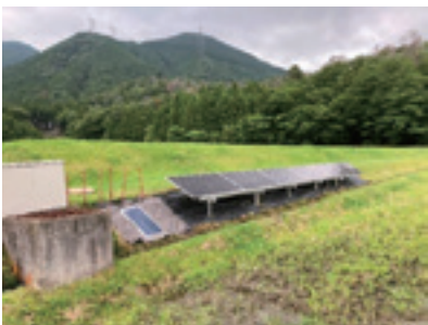
法面への太陽光発電施設設置
