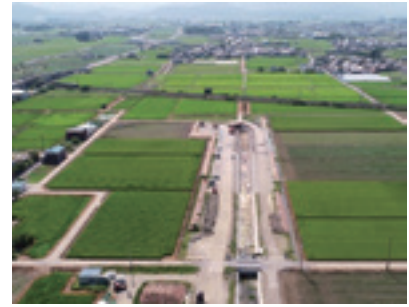
農業用排水路の整備
