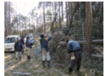
獣害防止柵の補修
