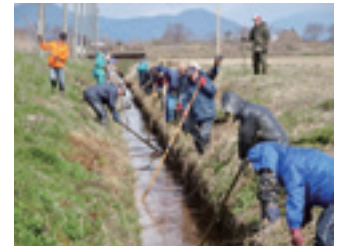
水路の泥上げ
