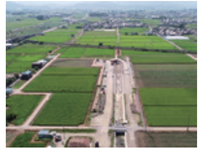
農業用排水路の整備
