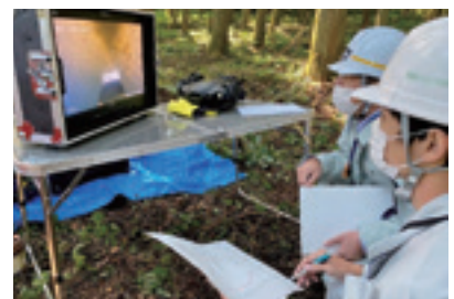
水路の機能診断調査
