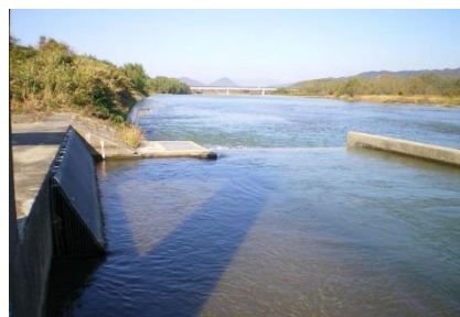
水口浄水場取水口（野洲川）
