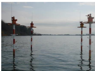
馬淵浄水場取水口（琵琶湖）
