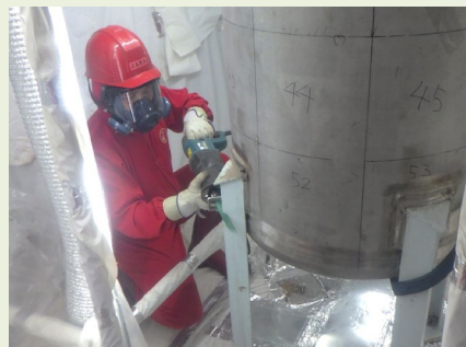
原子炉建屋地下1階の解体撤去 （解体中）
