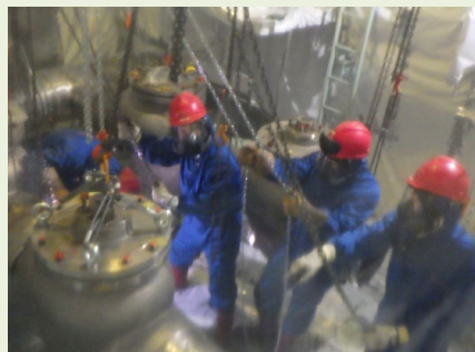
He連通弁廻りの解体撤去 （解体中）
