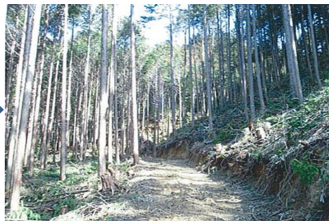
作業道施工後(間伐も実施)
