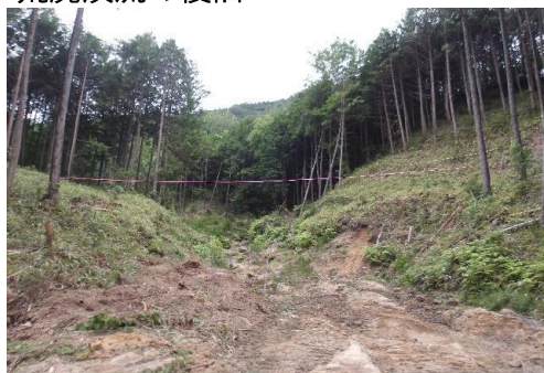
甲賀市甲南町塩野(施工前)
